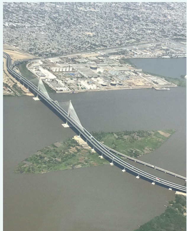
Puente Pumarejo. JL Castiblanco
