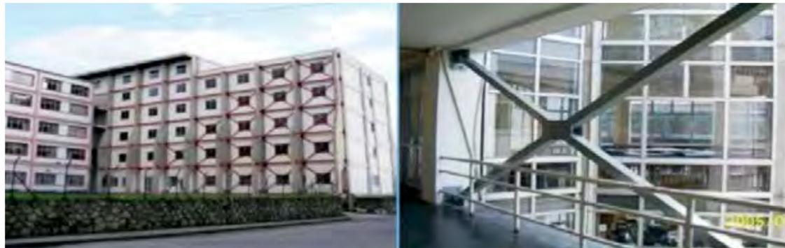
**Ilustración 5** » Imagen de la tecnología de amortiguamiento ante eventos sísmicos, aplicado en edificaciones en Japón
