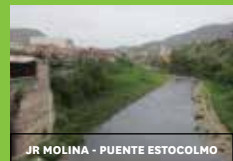
JR MOLINA - PUENTE ESTOCOLMO
