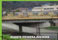
PUENTE PRIMERA AVENIDA
